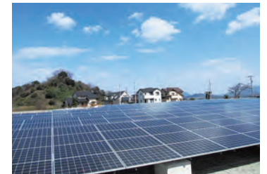
観音寺の自社太陽光発電所
