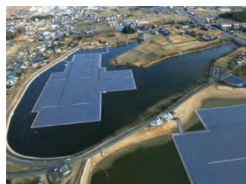
ため池の太陽光発電設備(東王田池)
