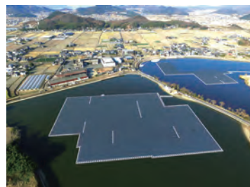
ため池の太陽光発電設備(中王田池)
