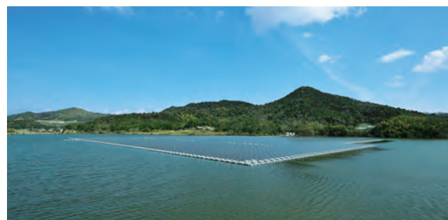
ため池の太陽光発電設備(野間池)
