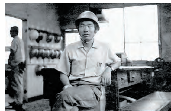
住友化学大江工場内のユタカ計装の詰所
