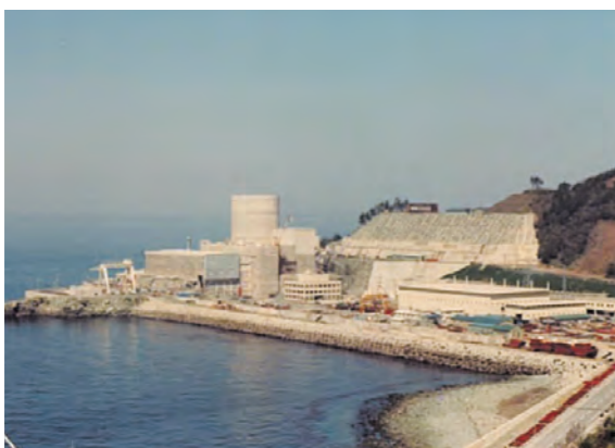
伊方原子力発電所1号機完成間近
