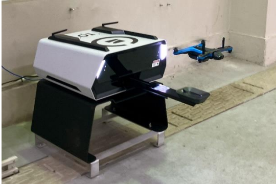
水力発電所内ソリューション設置
